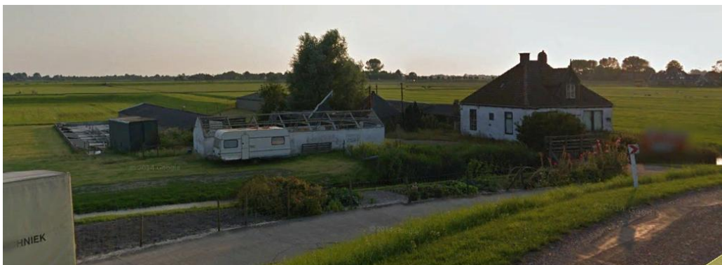
afb. 3 Het aanzien vanaf de IJsselmeerdijk voor de afronding van de sloop
