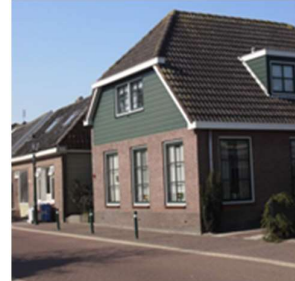
Een wolfseind is bij verbouw of renovatie niet toegestaan
