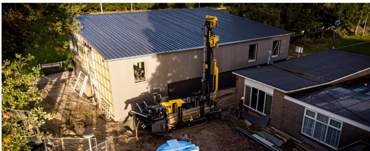
Figuur 7: Boren van een gesloten bron voor een grond/water warmtepomp. Foto: totaalenergieconcept.nl
